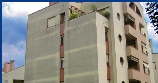
Il bagnamento delle superfici murarie aumenta notevolmente il coefficiente di conduttività termica ( $\lambda$ ) e comporta una perdita delle proprietà isolanti fino al 25-30%.
