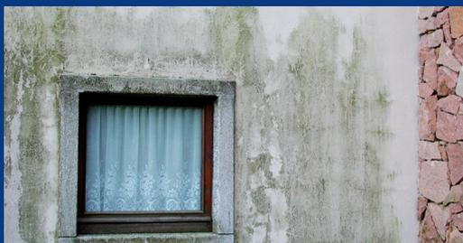
L'acqua, mantenendo la superficie umida, facilita la formazione di alghe e muffe e di un habitat ideale per la crescita dei microorganismi.
