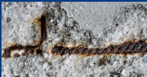
Penetrando in profondità nel supporto, veicola l'ossigeno e permette la reazione di ossidazione del ferro.
