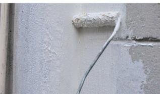
Annegamento della rete con l'aiuto di talocsa e rullo e successiva applicazione di una seconda mano di ELASTOLAC RASANTE QF e due mani di pittura ELASTOLAC.
