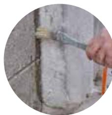
Pulitura e applicazione di isolanti delle fessurazioni all'interno
