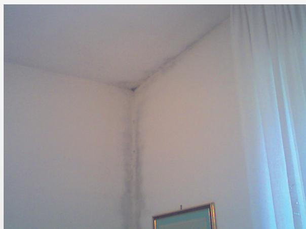
I ponti termici sono costituiti dalla discontinuità di isolamento termico che si può verificare in corrispondenza degli innesti di elementi strutturali: in questi punti si crea condensa di umidità che favorisce la formazione di muffe.
